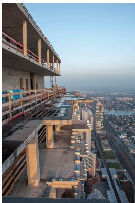
© Gmeiner Haferl Zivilingenieure ZT GmbH
