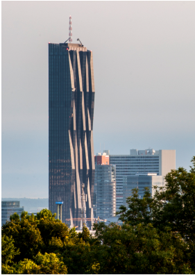
© Gmeiner Haferl Zivilingenieure ZT GmbH
