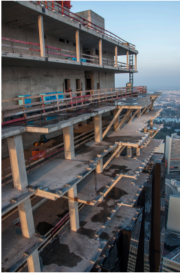
© Gmeiner Haferl Zivilingenieure ZT GmbH
