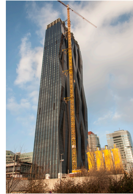
© Gmeiner Haferl Zivilingenieure ZT GmbH
