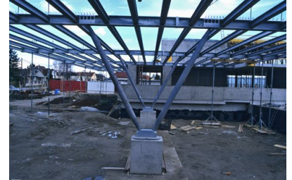
© Gmeiner Haferl Zivilingenieure ZT GmbH
