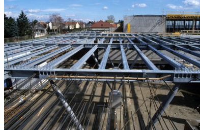
© Gmeiner Haferl Zivilingenieure ZT GmbH
